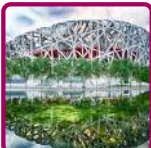
INSTALACIONES JUEGOS OLÍMPICOS: NIDO DE PAJARO Y CUBO DE AGUA
